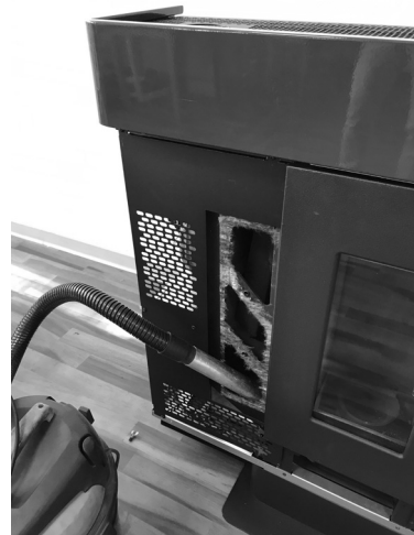
Fig. 38 - Reiniging rookgassenkamer
